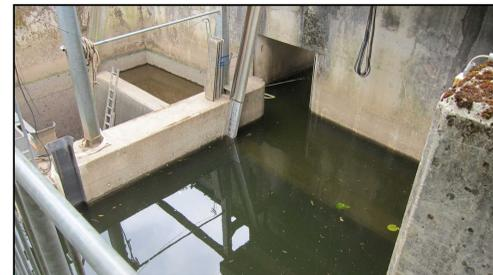
Blick von Oberwasser auf den rechten Turbinenkanal (dort Rechen überstaut), im Hintergrund sichtbar der Einlaufrechen des linken Turbinenkanals
